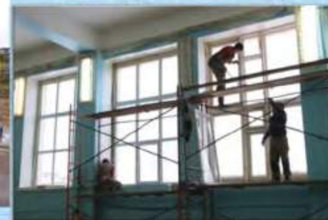
Ремонт оконных проемов и замена стеклопакетов в школе в рамках проекта «Реальные дела»
