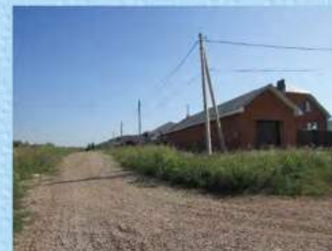
Капитальный ремонт уличного освещения в рамках проекта «Реальные дела»
