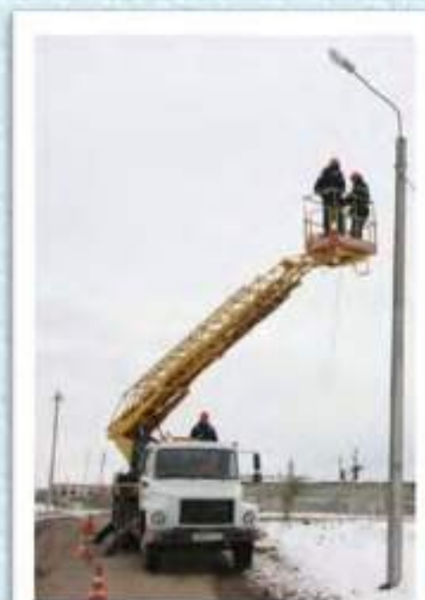
Капитальный ремонт уличного освещения в рамках проекта «Реальные дела»
